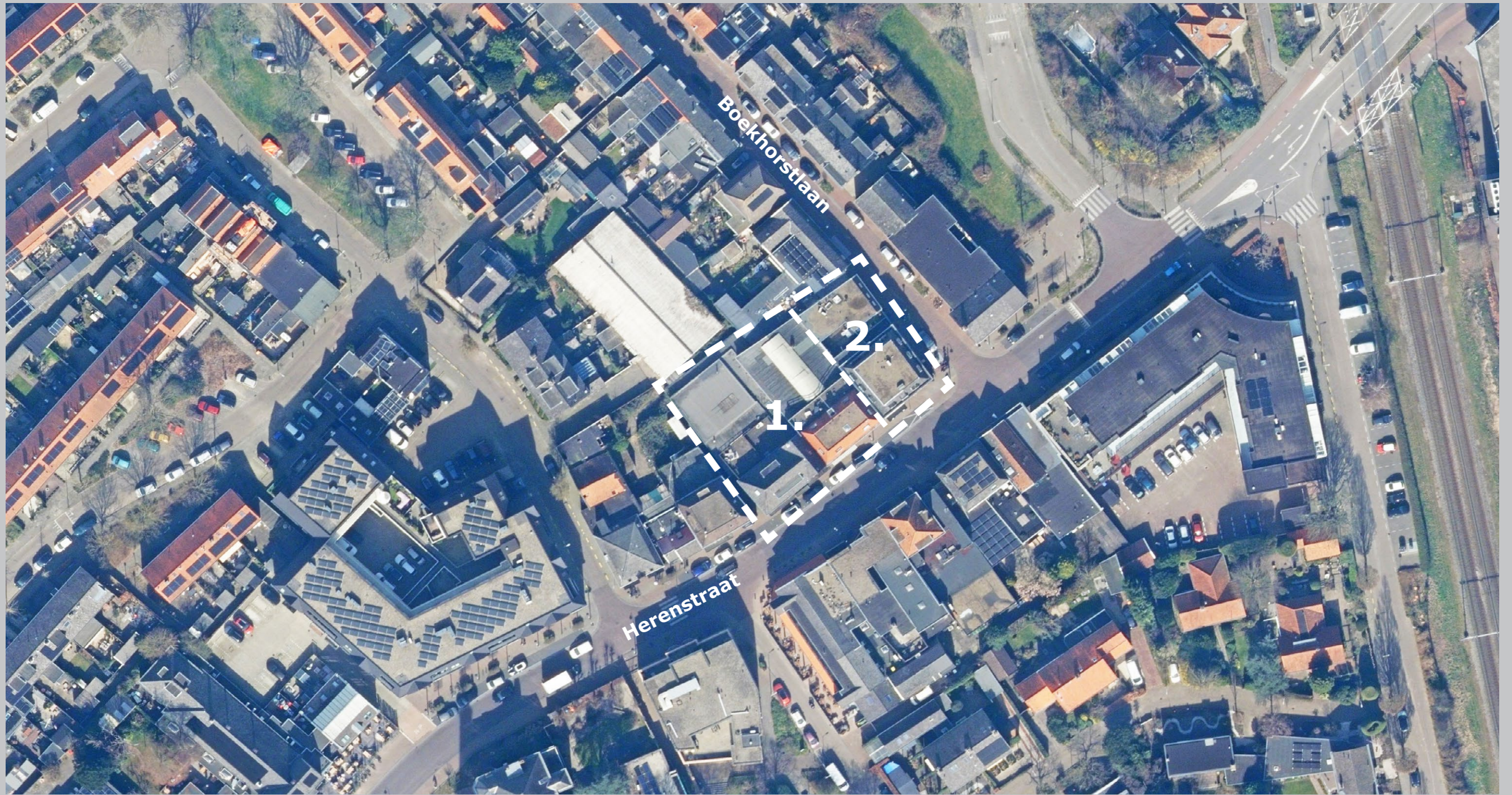
Luchtfoto bestaande situatie
